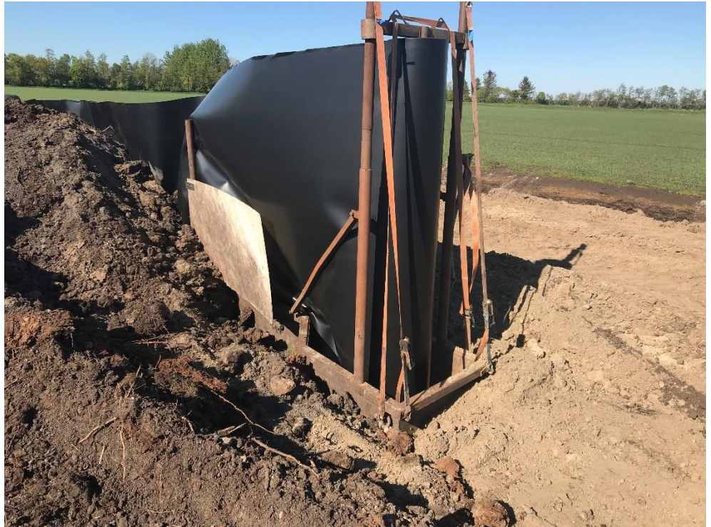
Figur 6-6 Billede fra etablering af plastmembranen i kanten af højmosen ved Aaby Mose. (COWI, 2019).
