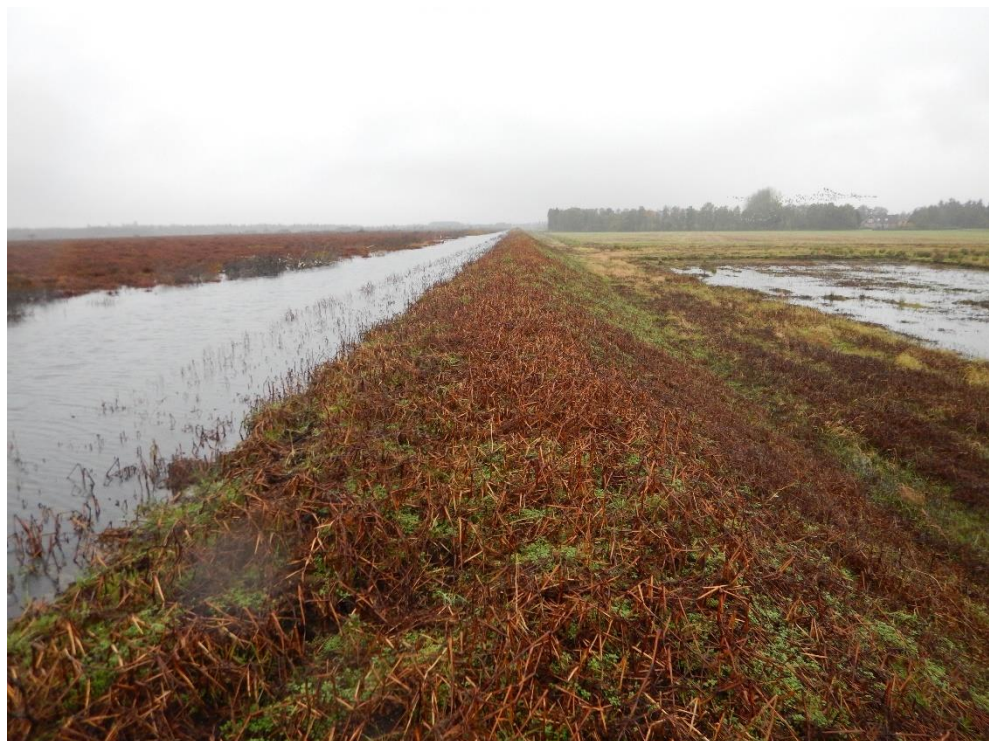
Figur 6-5 Dæmning med plastmembran etableret i 2019 mellem højmossefladen i Aaby Mose og landbrugsarealerne. (COWI, 2019).
