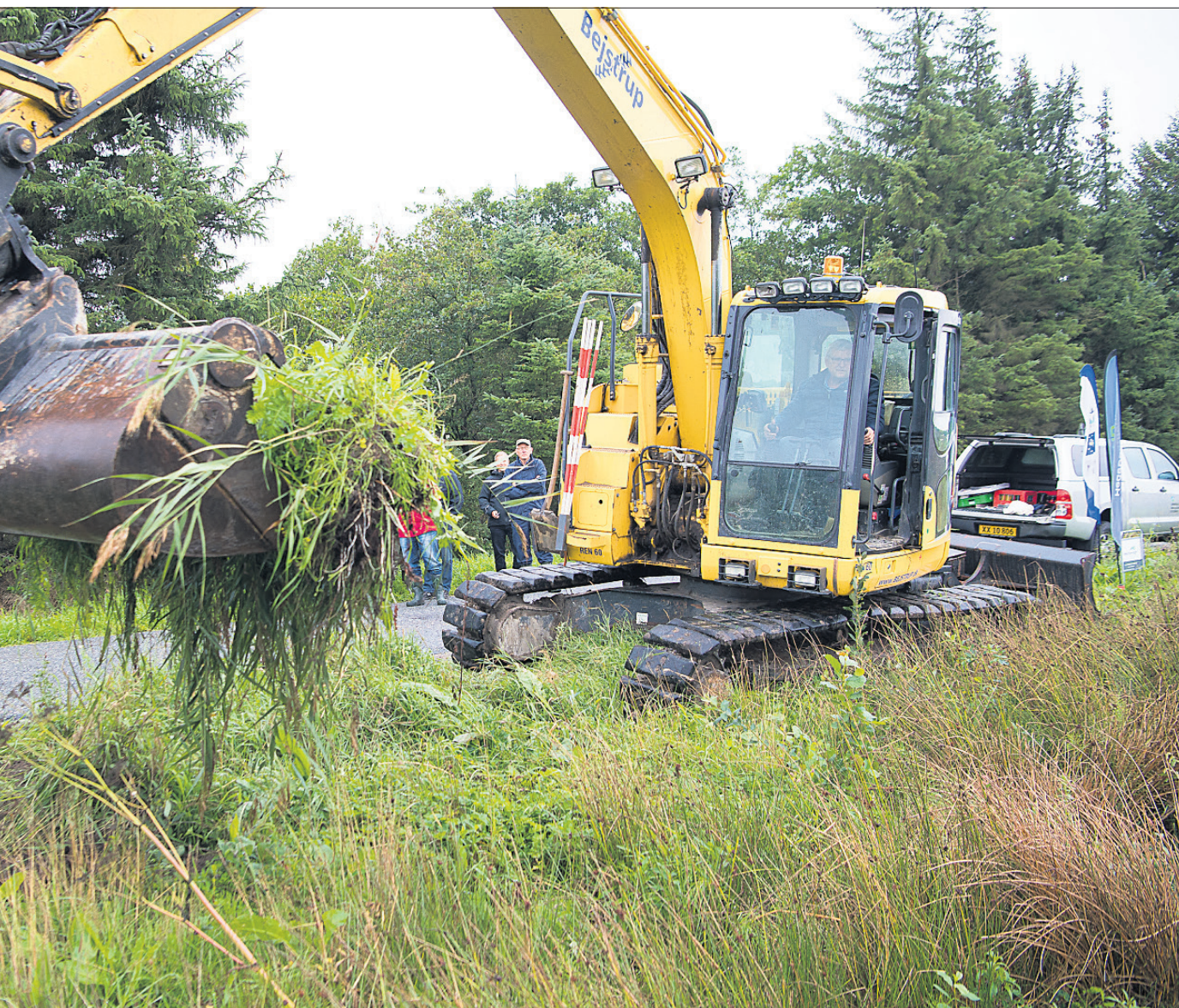
Så er etableringen af det tre kilometer lange dige i Store Vildmose i gang. Første spadestik blev foretaget af Jens Chr. Golding (S), formand for teknisk udvalg i Jammerbugt Kommune.
