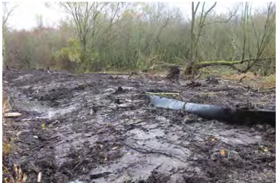
Figur 14: Eksempel på indbygning af membran ved genopretning af hydrologien i højmosen Storelung. Til venstre i billedet er membran afdækket med tørv, mens det endnu ikke er sket til højre i billedet.
