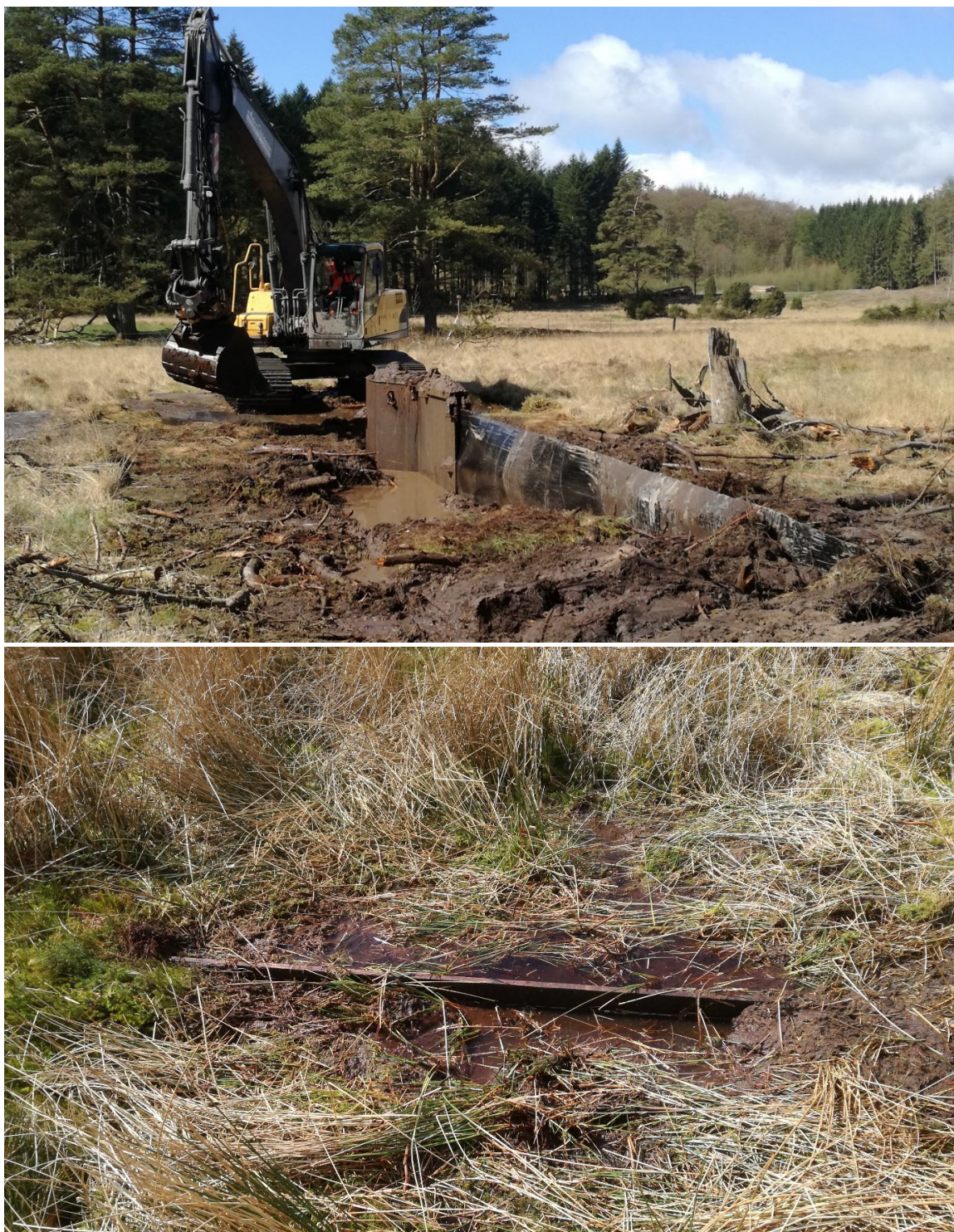
Figur 3 og 4. Isætning af vandstandsende membran og skodder i Langkær forår 2018.
