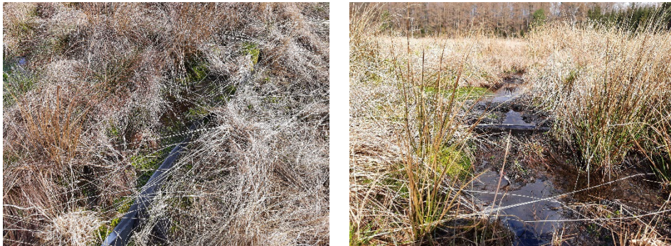
Figur 4 a og b. Vandstandshævning i Langkær gennemført ved hjælp af membran (t.v.) og krydsfinerplader (t.h.) 13. april 2021. Fotograf: Miljøstyrelsen.
