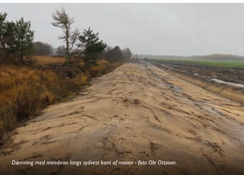
Anlæg af dæmning, samt membrannedlægning - foto Ole Ottosen.
