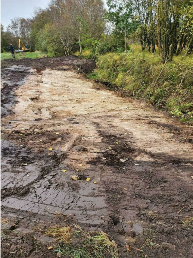
Anlæg 17: Blokering af grøft til terræn med brinkmateriale.
