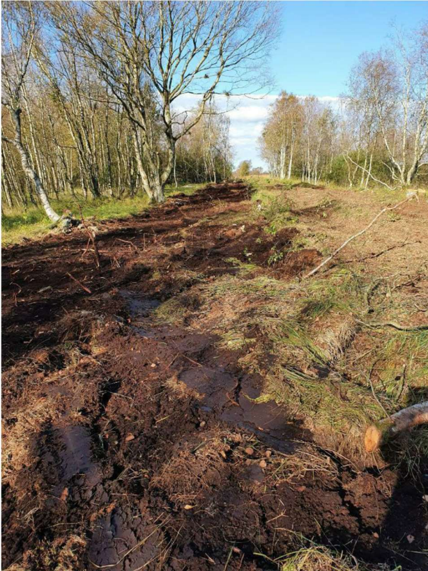
Anlæg 18: Blokering af 190 m grøft ved opfyldning til terræn.
