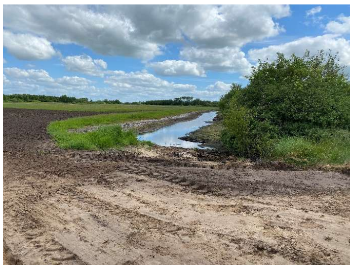
Anlæg 2: Afpropning med jord og træplade til terræn ud mod skelgrøften mod vest.
