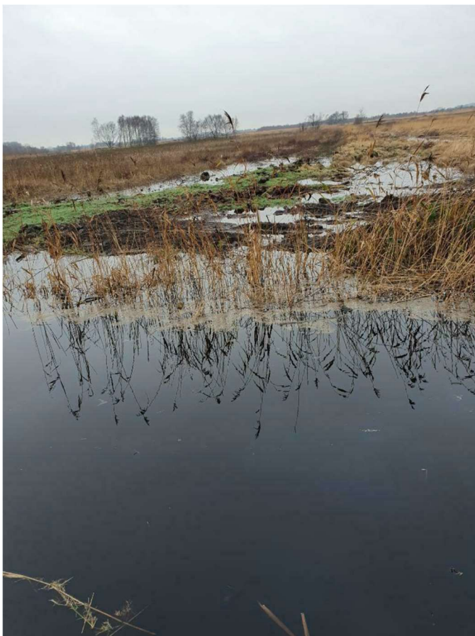
Anlæg 23: Blokering rørudløb ved opgravning og ilægning af jord.
