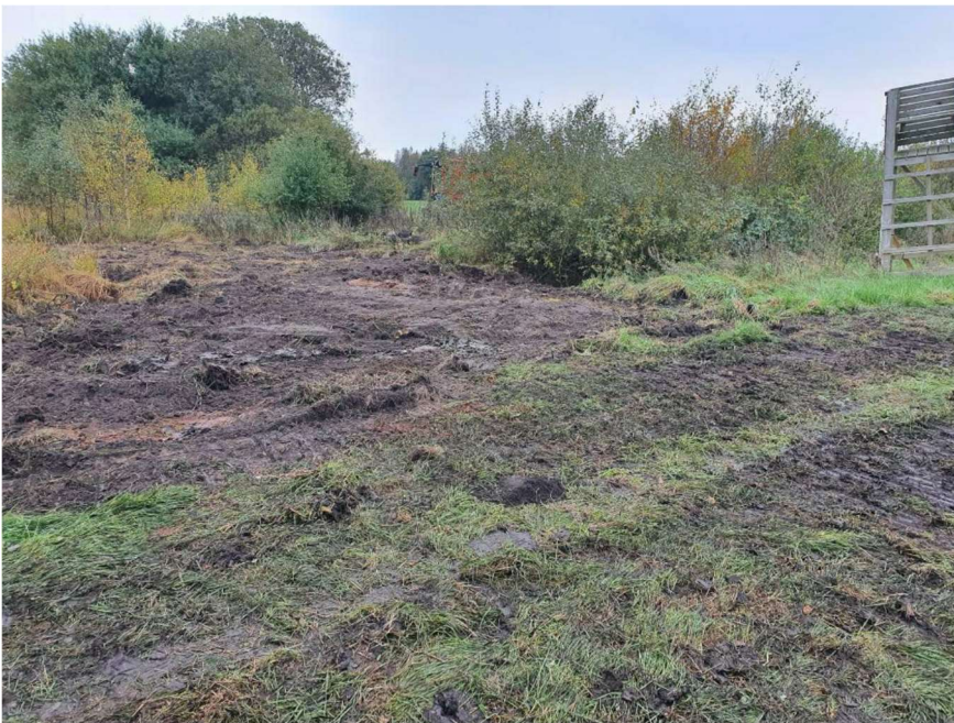
Anlæg 16: Blokering af grøft i overkørsel ved opgravning af rør og opfyldning til terræn.
