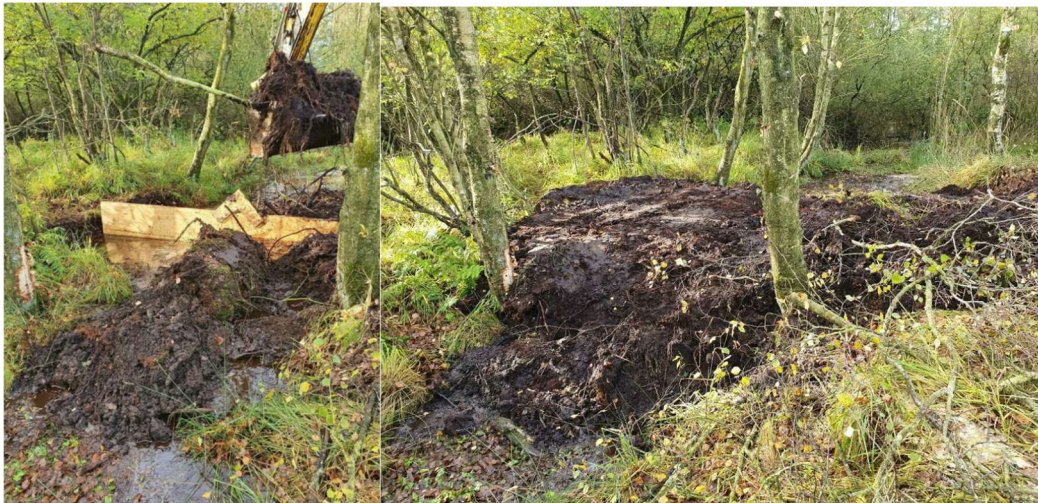
Anlæg 20: Blokering af grøft med træskod og jord til terræn.
