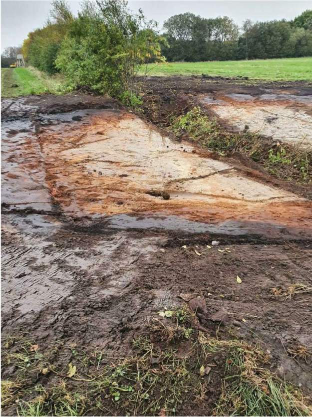
Anlæg 15: Blokering af grøft til terræn med brinkmateriale.
