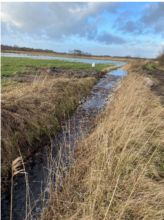
Anlæg 25: Opstemning med jernplade med udskæring efterfulgt af stenstryg. Overkant af jernplade er i kote 16,90 m, og udskæring i kote 16,70 m.
