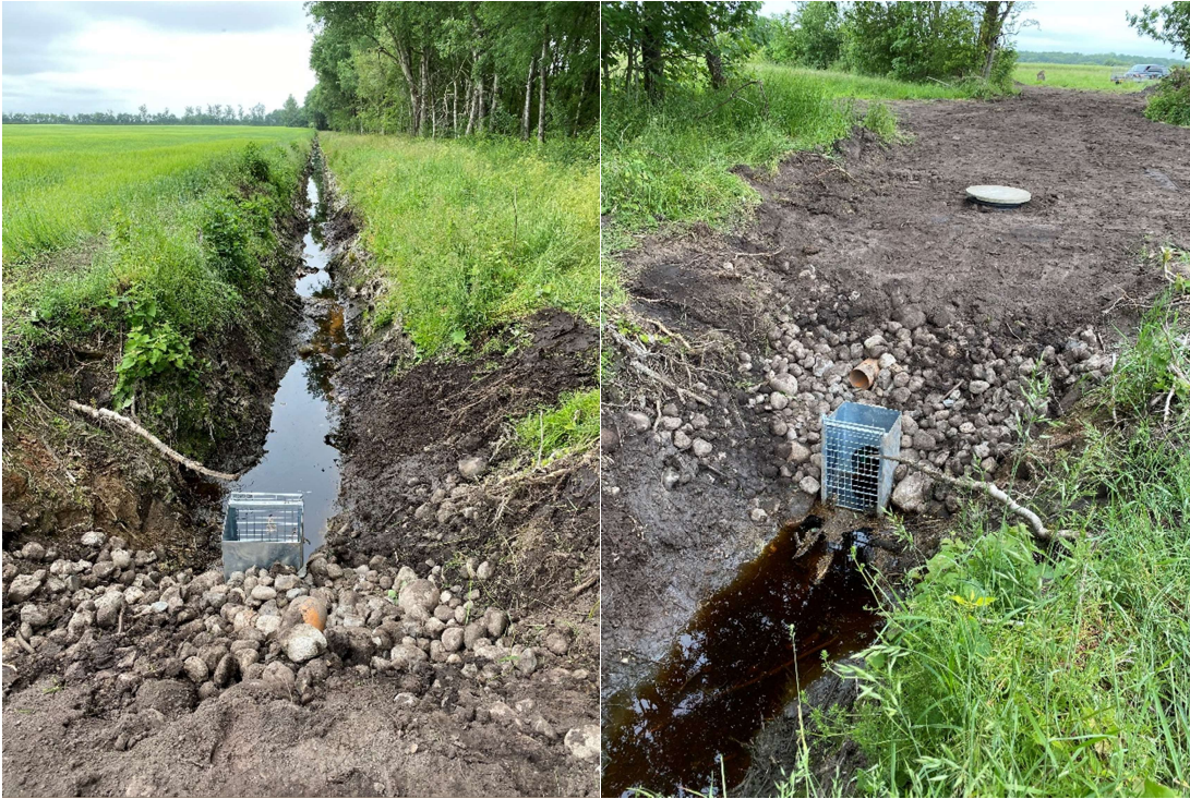
Anlæg 24: Indløbsbrønd fra skelgrøft, indløbskote af rør 15,9 m.
