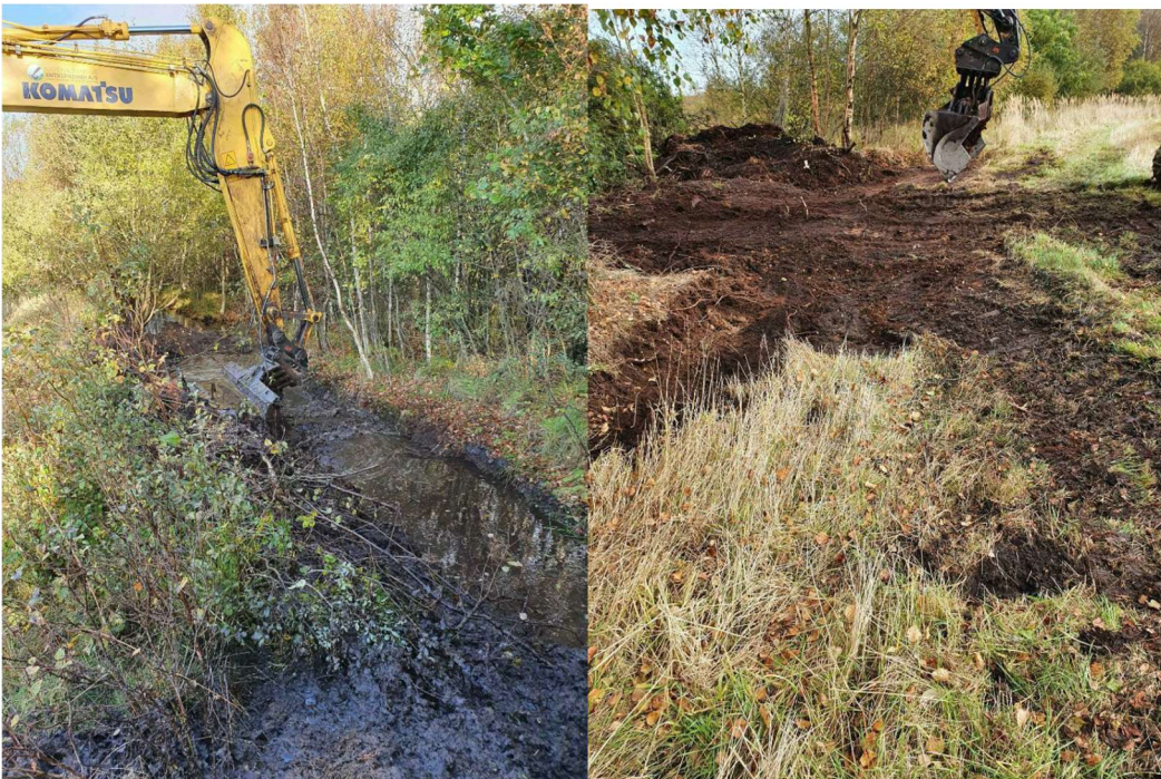
Anlæg 14: Blokering af 150 m grøft med jord til terræn.
