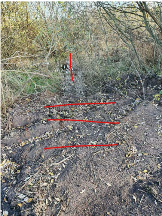
Anlæg 10: Blokering af grøft til terræn.
