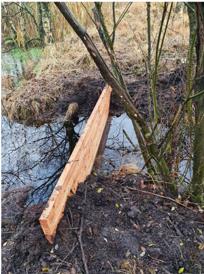
Anlæg 21: Opstemning af vandløb med træskod med overkant i kote 17,00.
