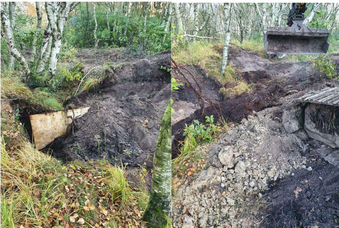
Anlæg 19: Blokering af grøft med plade og jord til terræn.
