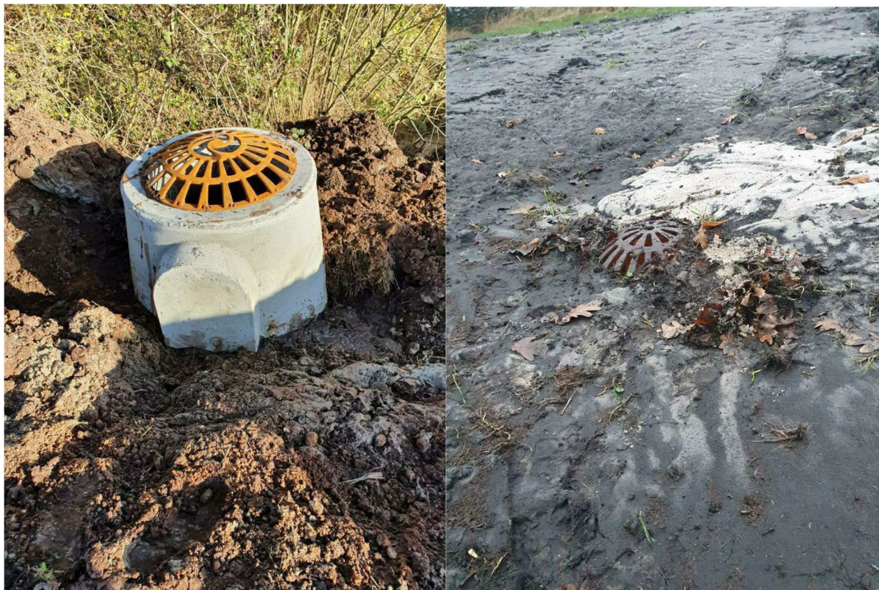
Anlæg 1: Brønd med kuppelrist. Overkant kote 18.10. Tilløb i kote 16,09 med forbindelse til skelgrøft mod vest. Afløb mod nord i kote 15,9 m DVR90.
