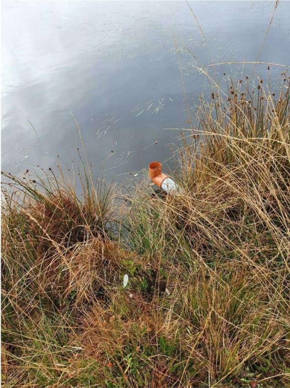
Anlæg 11: Hævet afløbskote til kote 17,50 m.
