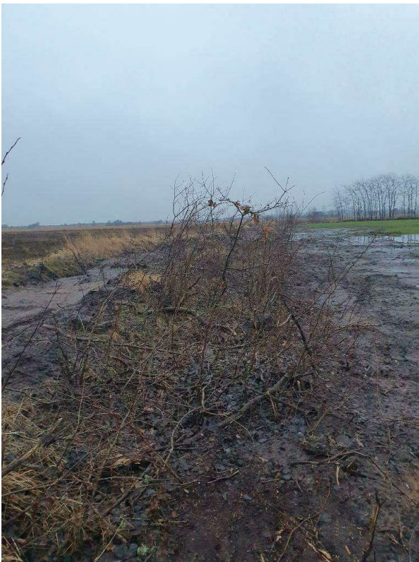
Anlæg 12: Blokering af 125 m grøft ved opfyldning med jord til terræn.
