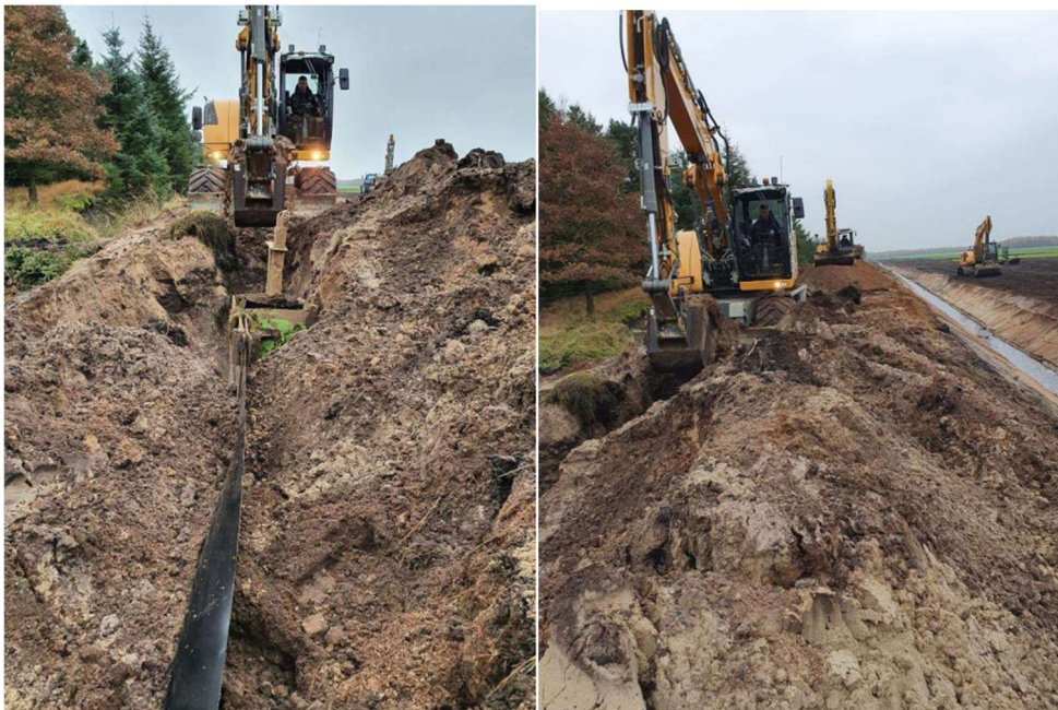
Membran under etablering (anlæg 1)
