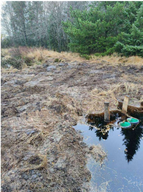
Punktblokeringer af grøfter med etablering af regulerbare rørlægninger (anlæg 9 og 12)
