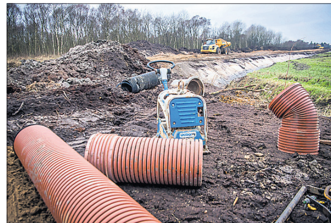
I forbindelse med anlægsarbejdet er der fældet træer, lavet nye vandløbsforløb, skiftet røroverførsler og lavet nye adgangsveje.
